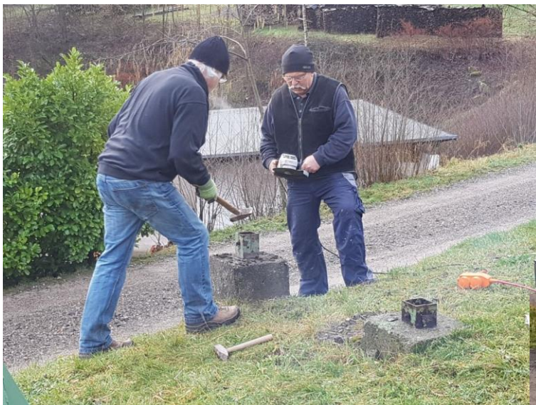
Die abgerissenen Halterungen werden abmontiert
